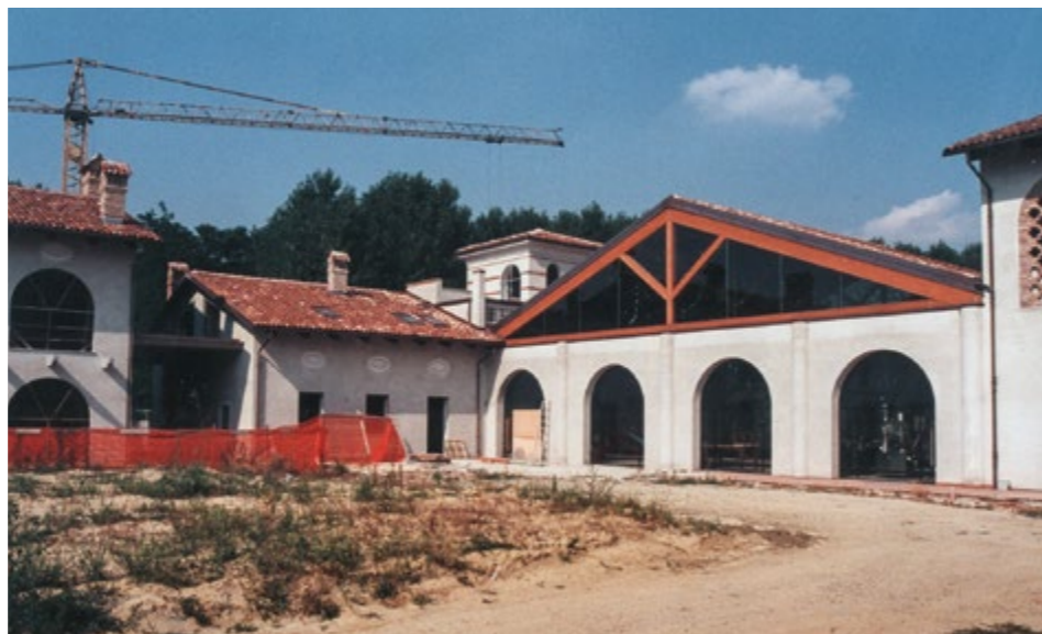
La costruzione della nuova cantina Sandrone
